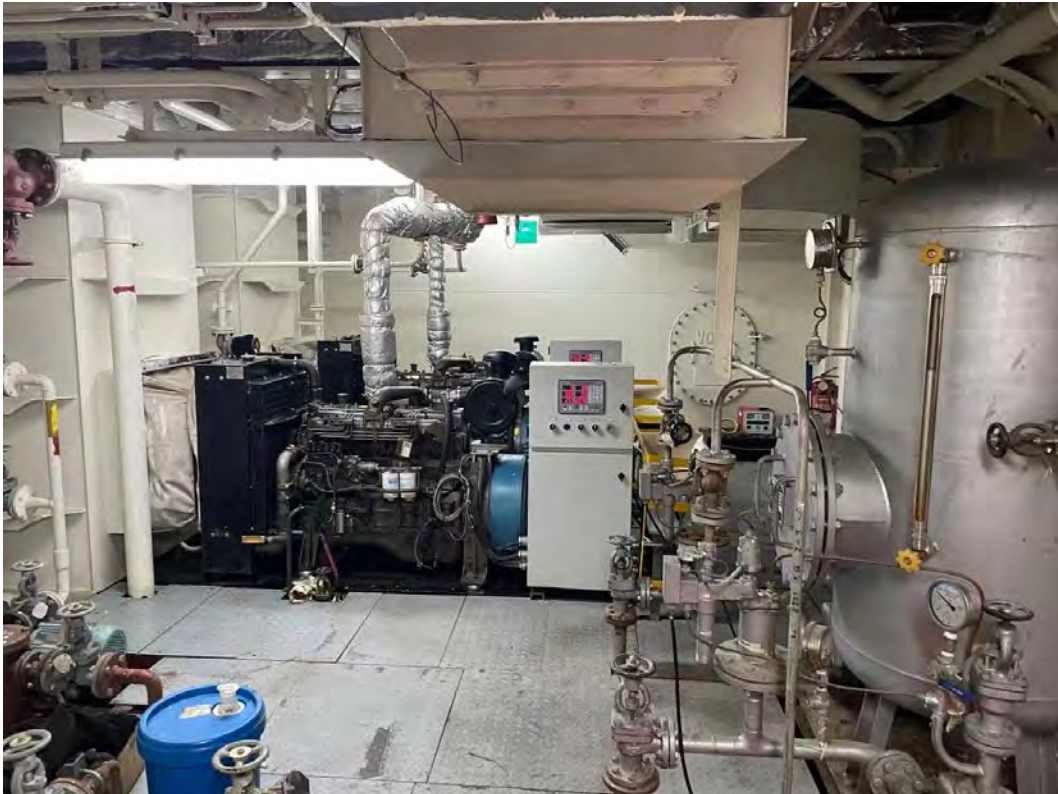
图 2.6-3 柴油发电机消音器及燃油柜
